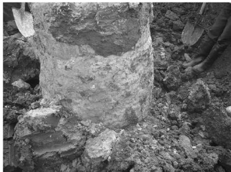
图3 冲击成孔桩身包裹的如石蜡粉的薄泥皮
