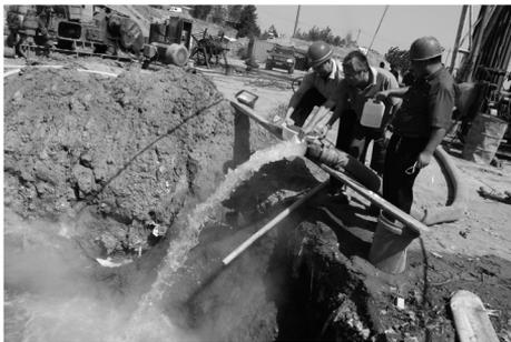
龙门地处洛阳市区南郊,著名的龙门石窟就位于此。2013年5月,业业主邀请,该公司派出地质人员对龙门一带地热地质进行实地勘查,经过资料收集分析、实地踏勘、圈定成井靶区,并在多种物探工作基础上,在疑似断层附近确定了井位,设计井深 $1200\text{ m}$ 。该地热井于2013年6月25日开钻,8月18日完井。
