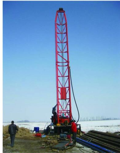
图5 SPT-1500型拖车钻机施工现场
