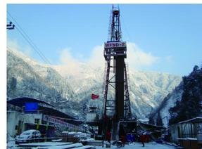
项目钻探施工总进尺 10387 m,其中取心钻进 5883 m,获取岩心 5378 m,平均岩心采取率 91.4%。针对龙门山断裂带极端恶劣的施工环境和复杂的地质条件,该项目的钻探技术人员开展了大量的自主创新,研
