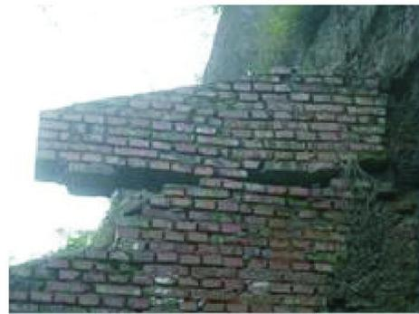
(c) 基岩陡壁向前推挤挫断围墙
