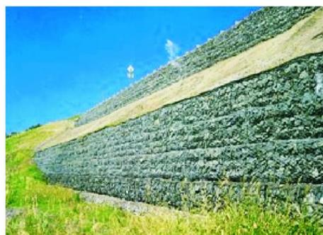
图3 加筋格宾挡墙示意图
