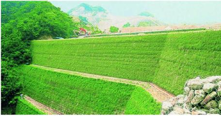
图5 绿色加筋格宾挡墙示意图
