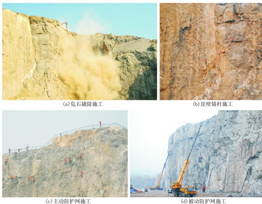
图 2 现场部分施工工艺照片
