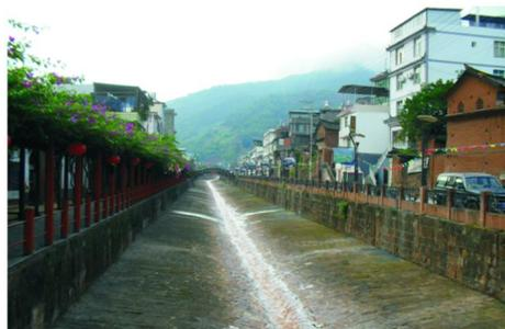
图1 复式V形排导槽
