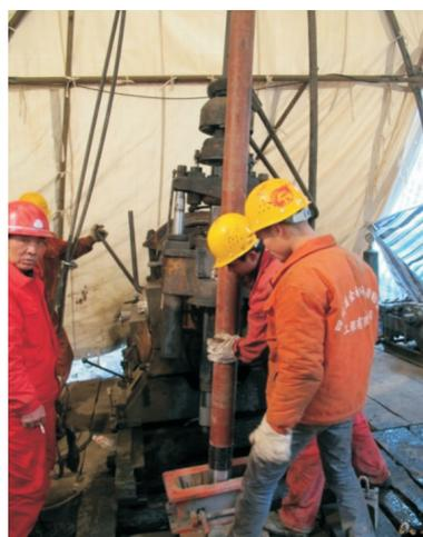
图 3 下套管 (下钻)
