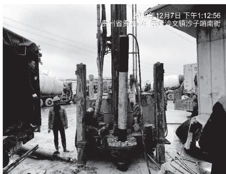
图6 膨胀管护壁技术应用
