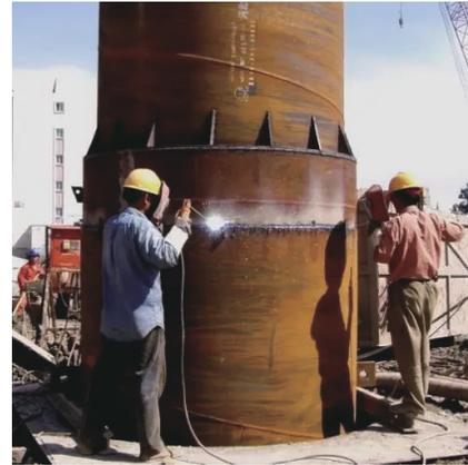
图4 大口径套管人工焊接
