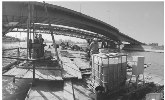
图3 浏阳河水下岩溶注浆作业平台
