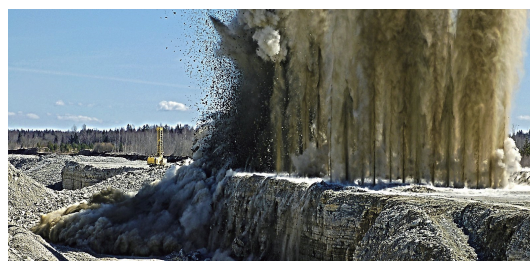
图1 爆破作业现场
