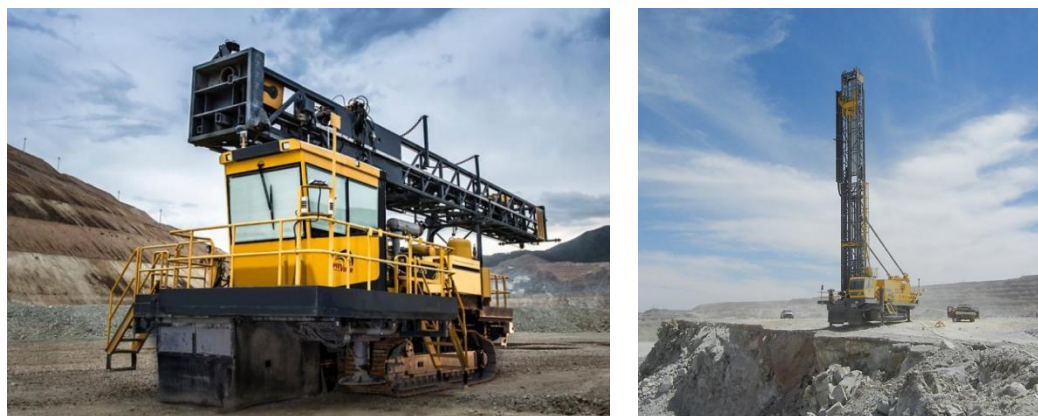
图8 爆破孔钻机施工现场
