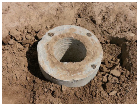
图7 桩头打磨整平
