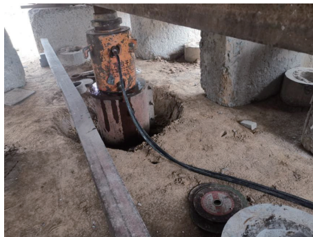
图9 不合格桩复压施工
