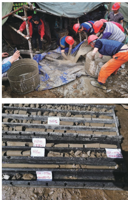
图4 某钻探现场水泥基材料护壁堵漏
