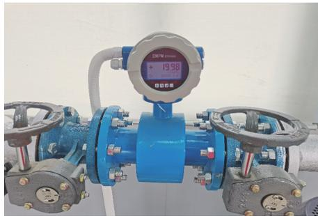
图 7 电磁冷热流量计、电磁流量传感器
