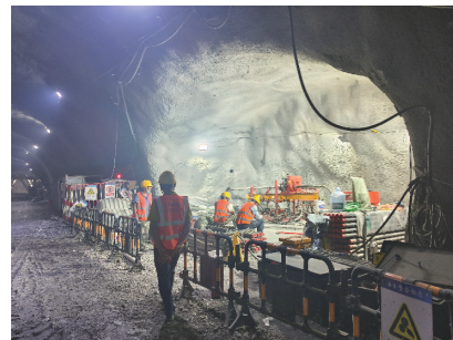
图6 水平定向钻孔施工现场
