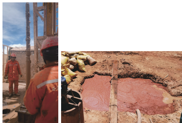
(a) 泥岩严重造浆导致钻具结垢
