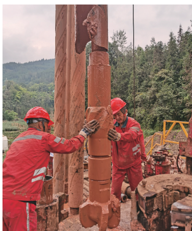
图7 掉井螺杆及钻头出井
