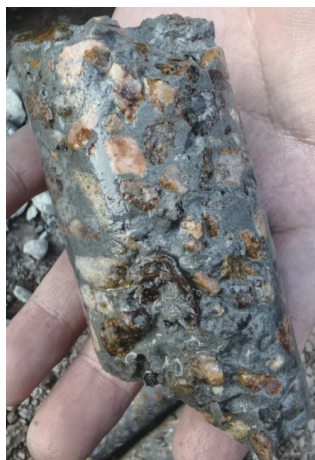
图8 膨胀架桥水泥砂浆封堵效果
