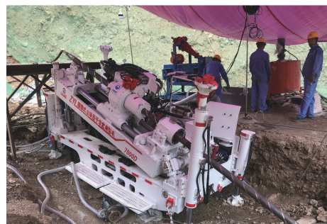
图3 定向钻孔现场施工
