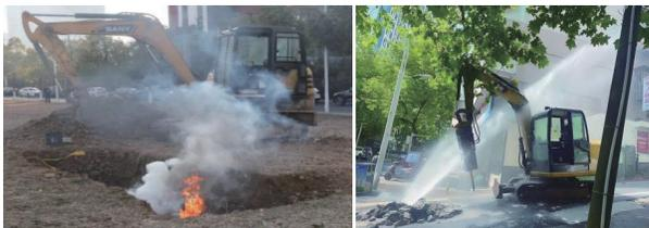
(a)燃气管线施工交叉事故 (b)施工现场水管被扎穿
