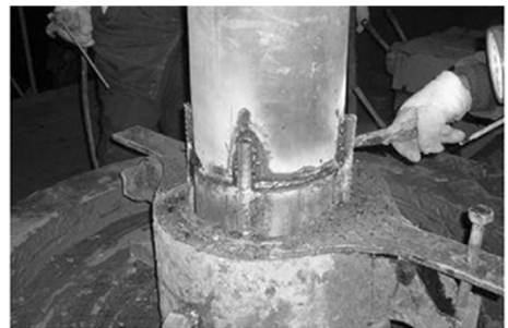
(a) 管体井口焊接
