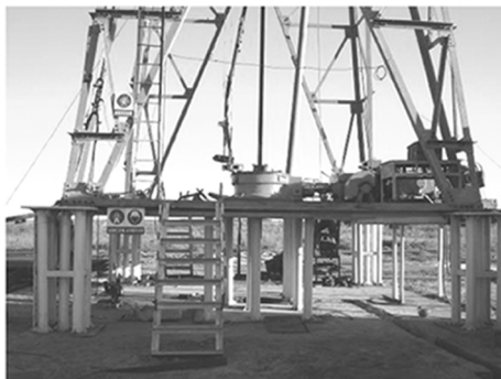
(b) 施工现场
