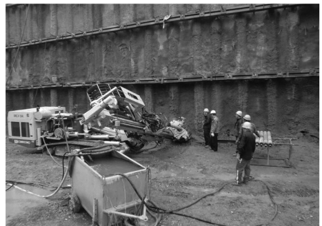
图2 钻机施工现场
