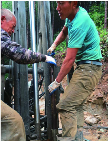
图3 投放内管总成
