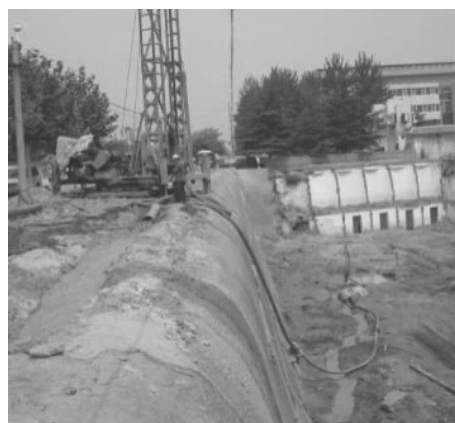
图 6 坡顶钻进坡底泥浆循环施工现场
