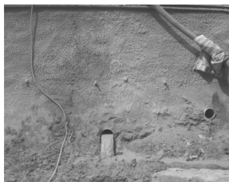
图 5 人工挖孔桩底平洞及 PVC 管现场
