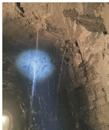
图 4 注浆前射流出水
