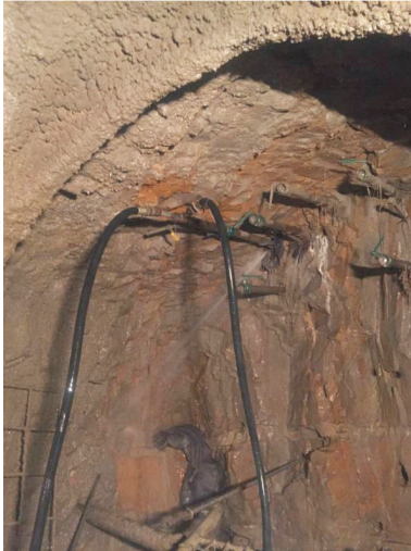
图5 注浆达到控制渗水效果 Fig.5 Grouting sealed off water seepage
