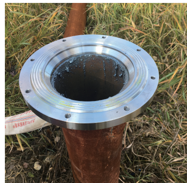
图6 安装下法兰盘
