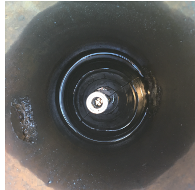
图5 管内临时止水
