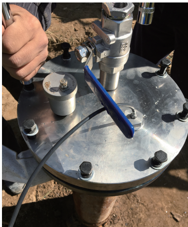
图7 安装金属盖板
