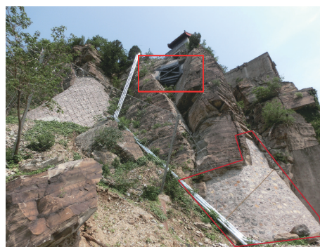
图14 危岩体(WYT7)斜撑内支撑环治理工程竣工效果(远观)
