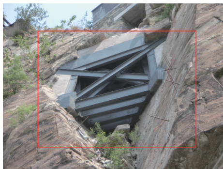
图15 危岩体(WYT7)斜撑内支撑环治理工程竣工效果(近观)
