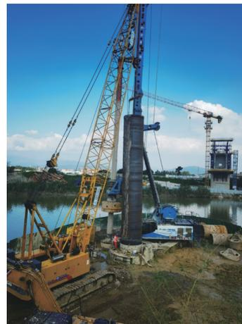
图 12 2650S 搓管机施工现场
