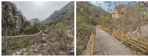
(a) 竣工后的挡墙
