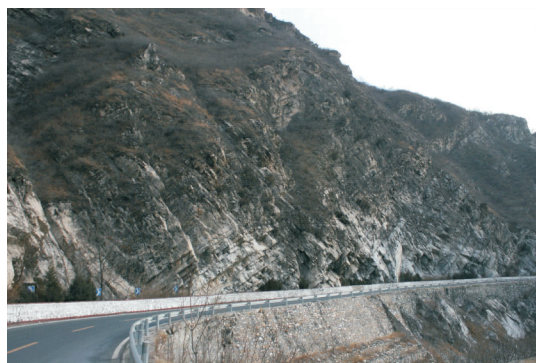
图3 贾金路地灾治理段区域地貌现状
