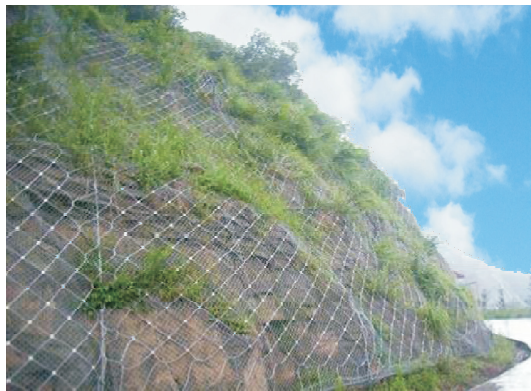
图18 治理区域现场工况图
